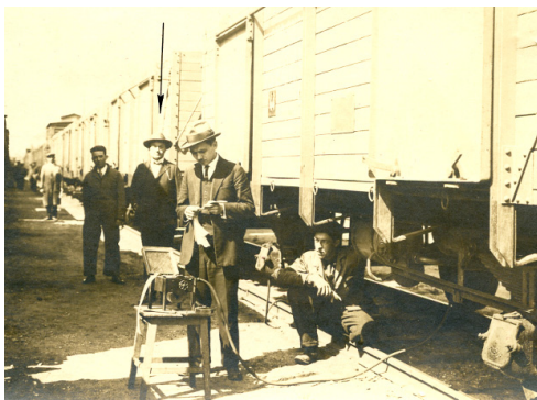
Слика 9. Испитивање функционалних карактеристика кочнице “Божић” [18]
