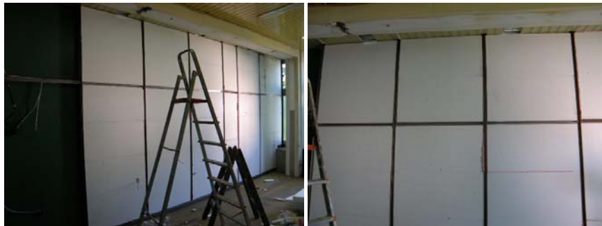
Радови на реконструкцији старог деканата
