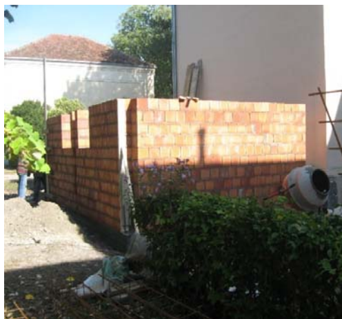
Објект у изградњи
