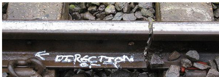
Слика 4.25. Крти лом шине (NetworkRail, Енглеска)
