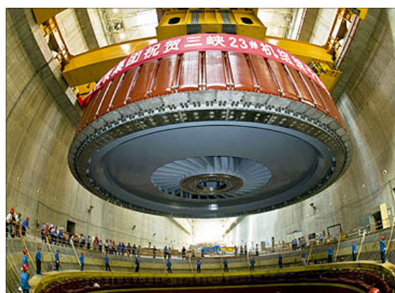
Сл. 3.: Статор синхроног хидрогенератора
