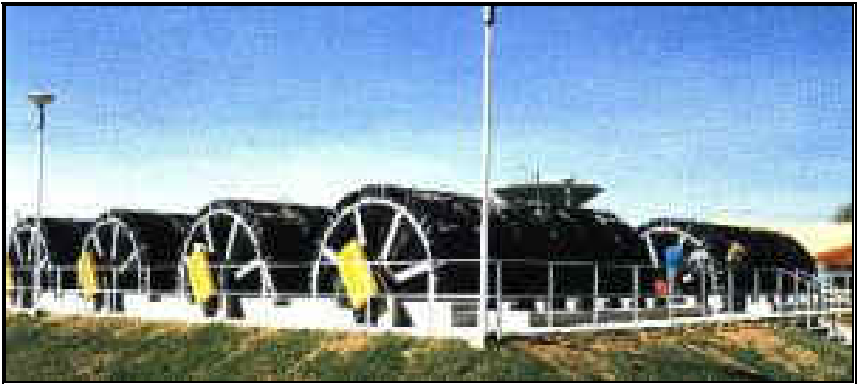
Slika 3.2. Višestruka instalacija RBK-a prečnika 3,66m /13/
