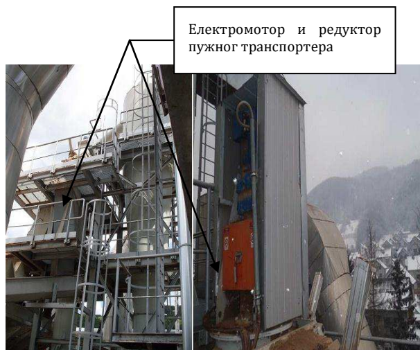
Слика 8. Вертикални пужни транспортер пре и после акустичке заштите
