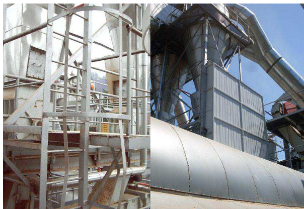
Слика 9. Зауставе међуслоја – пре и након звучне заштите
