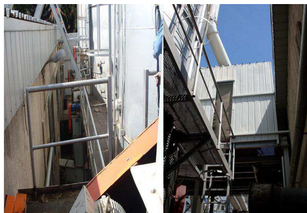
Слика 10. Вентилатор за додатно одсисавање са иверача – пре и након звучне заштите
